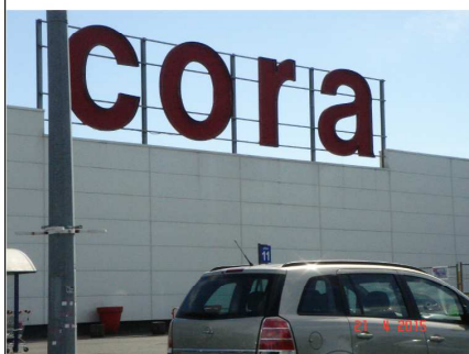
Sur toiture ou attique
