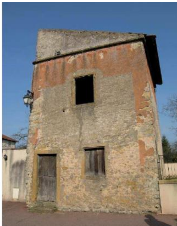
Vestiges de la maison forte
