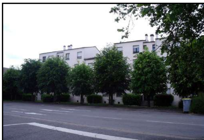
Opération rue du Forgeron
