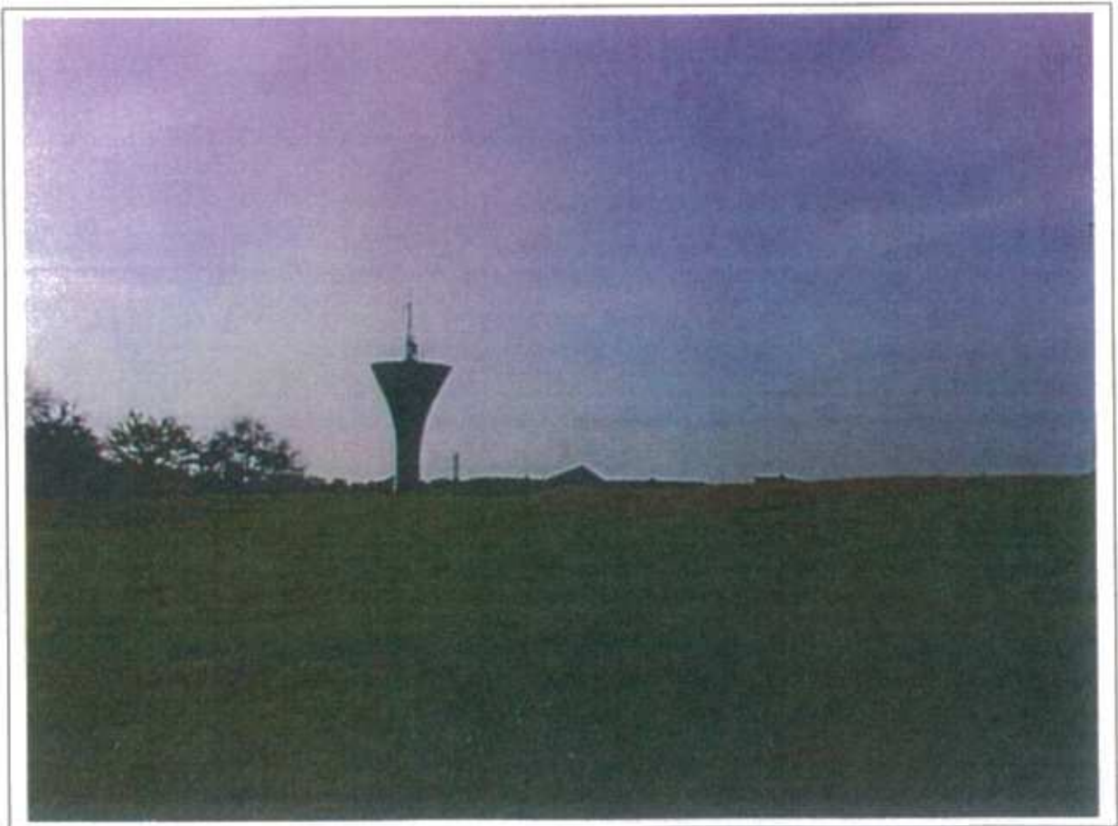
Réservoir d'eau du S.E.B.V.F
