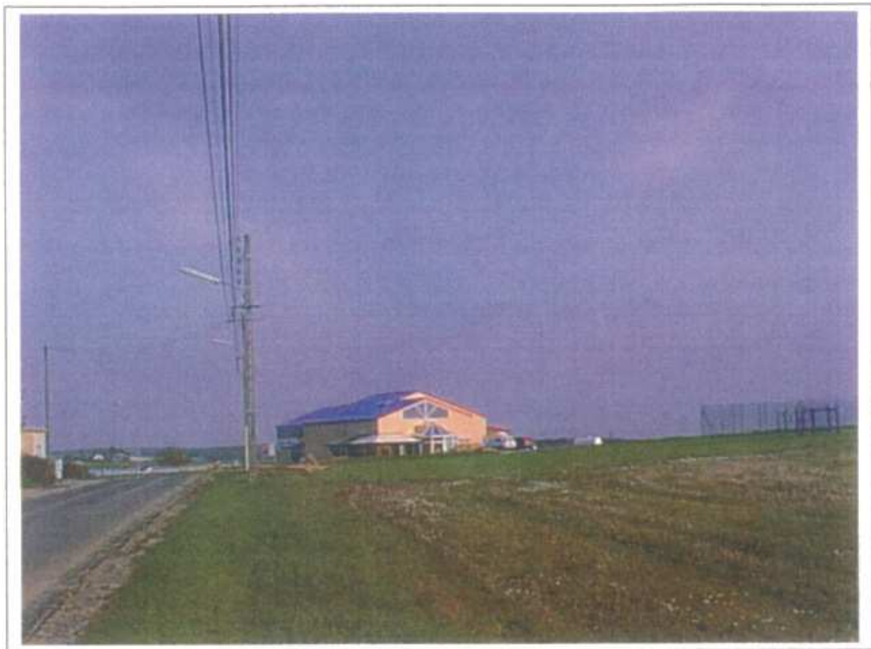
Usine de fabrication de châssis P.V.C et vérandas
