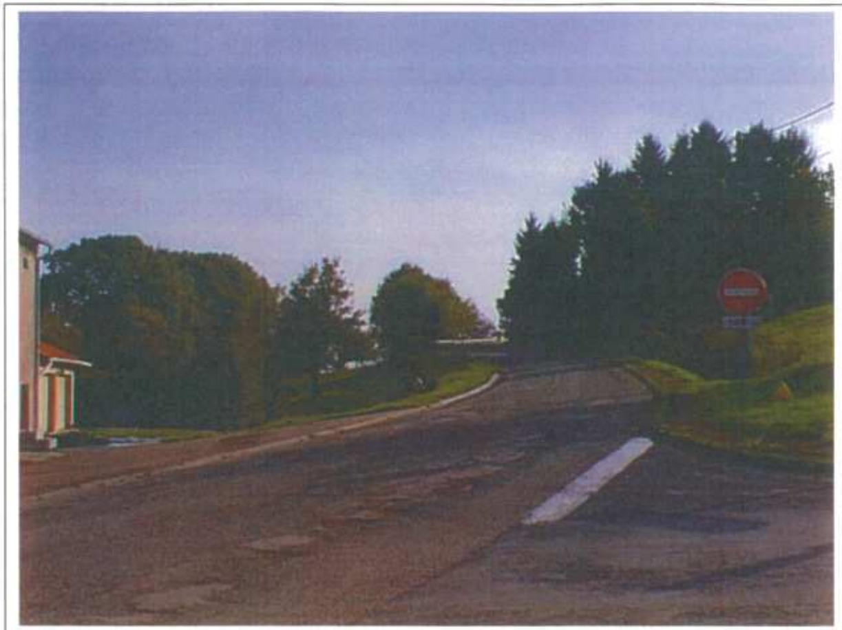
L'ancien accès depuis la RD 910 – Toujours beaucoup de végétal
