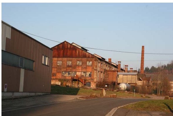
Ancien bâtiment de la cristallerie
