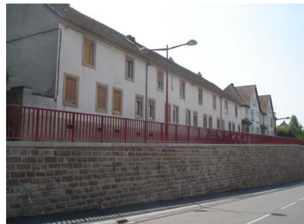
Habitat ouvrier Rue de la Libération
