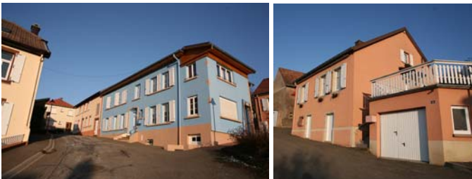
Construction dans la pente
