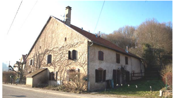
Construction dans la pente
