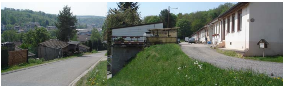
Rue du Belvédère et maisons en bande avec garages le long du chemin d'accès
