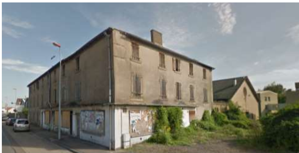
Immeuble désaffecté, 30 rue de Hayange
