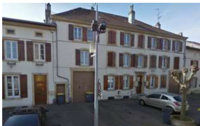
Maison pré-industrielle, 24 rue de l'église.
