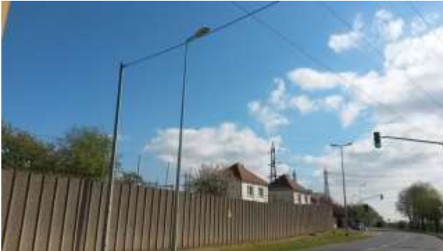
Clôture du poste électrique et habitations de la cité du poste EDF
