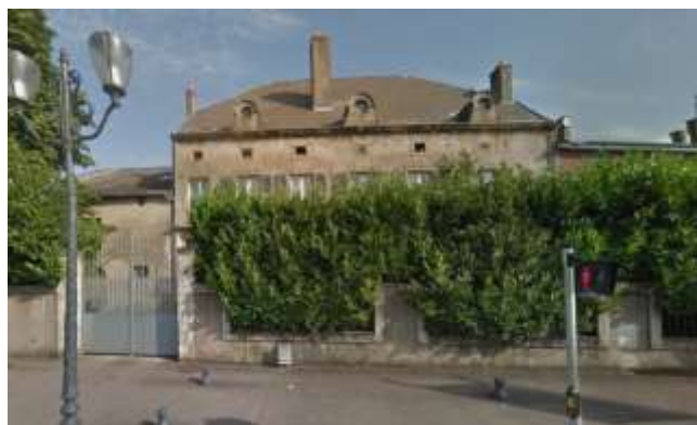
Ancien corps de ferme, 31 rue Jeanne d'Arc.
