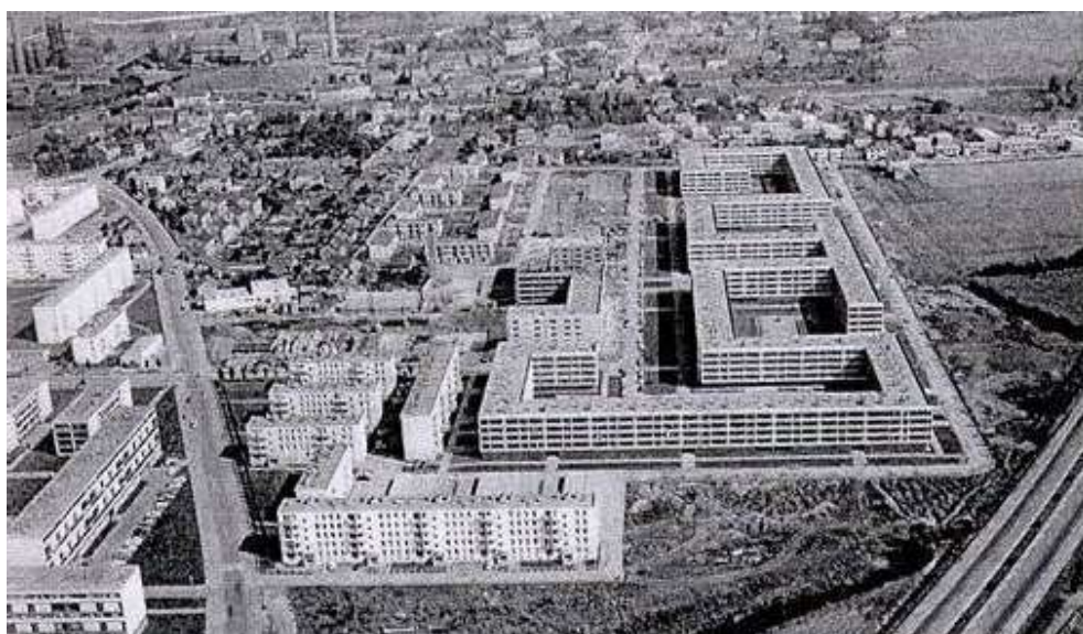
Vue aérienne du quartier Ouest en fin de construction.
