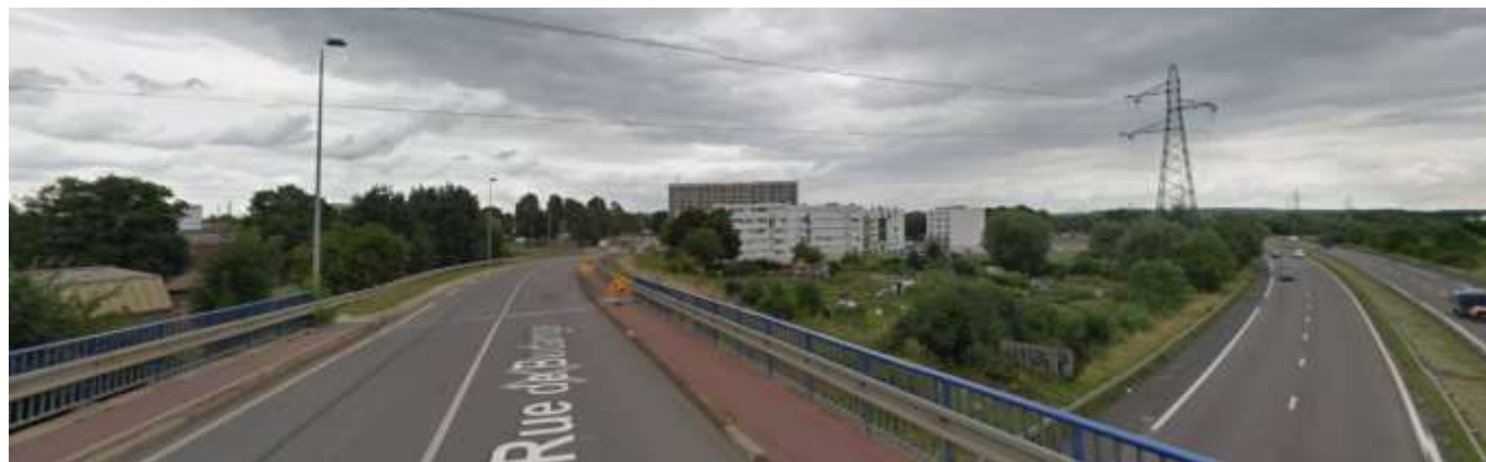
Séquence 3 : pont de l'A30. L'arrivée sur le pont marque l'entrée dans la ville. Les collectifs et les jardins ouvriers sont les premiers éléments observés.
