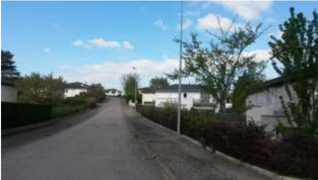
Vue générale depuis la voie principale.
