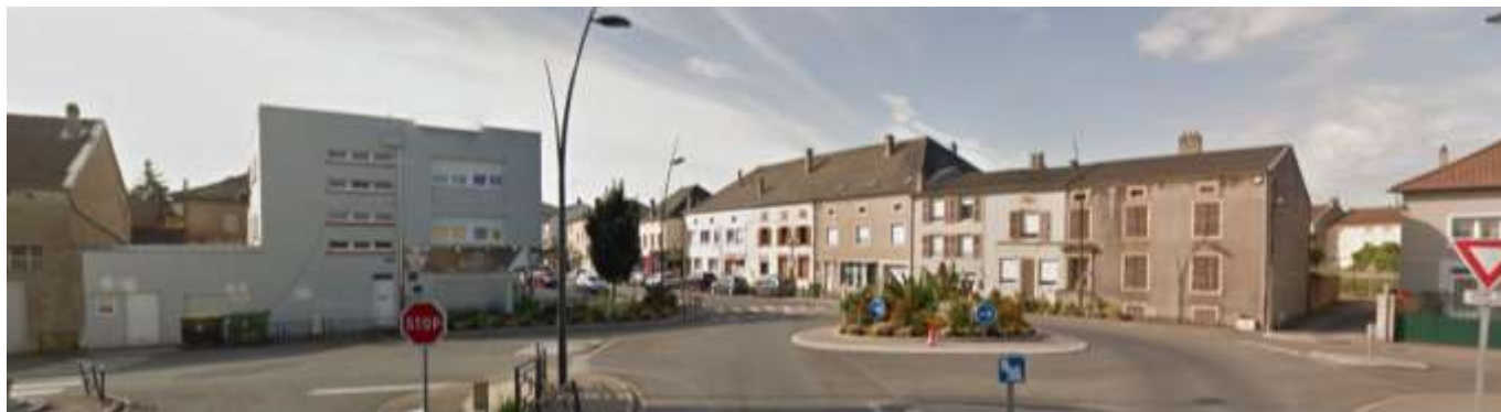
D952 vers la rue de la gare : Le volume cubique du bâtiment sur la gauche et la composition épurée de sa façade sont incohérents avec le bâti traditionnel du cœur de ville
