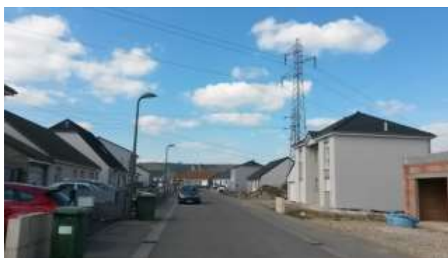
Boucle de voirie et constructions attenantes.
