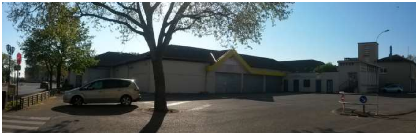
Façade arrière, donnant sur le vaste parking.
