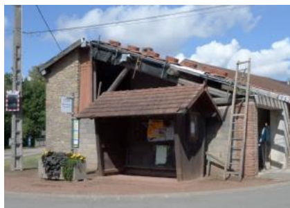
Arrêt de Bus de Gongelfang
