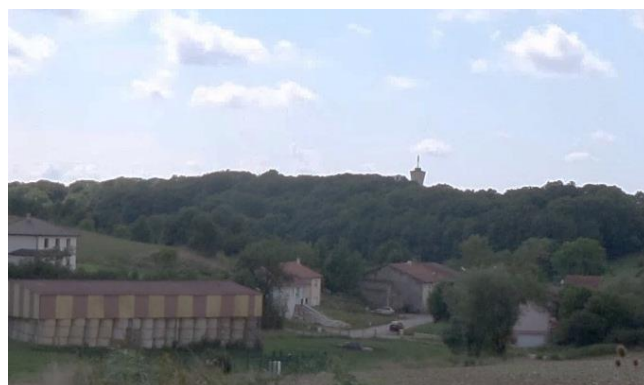
Le château d'eau vue depuis Gongelfang
