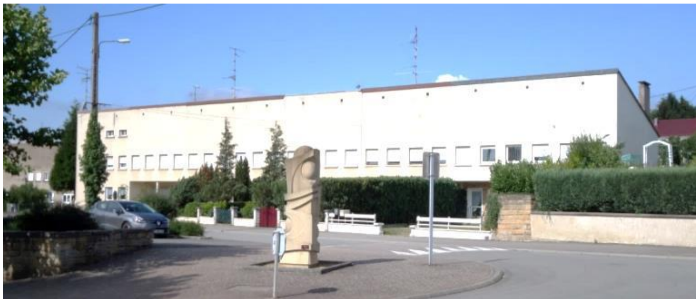
Bâtiment caractéristique de la reconstruction, rue de Mornant
