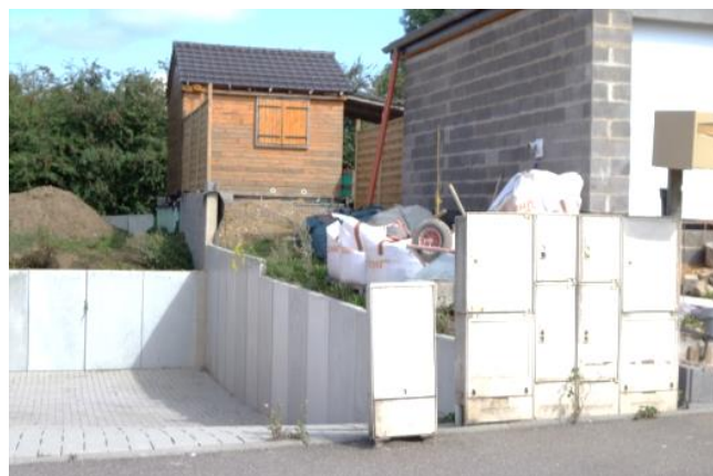
Exemple de mur de soudainement et de terrassement au sein du lotissement
