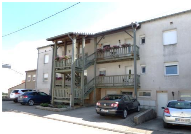
Création de coursives extérieures, Rue des Ecoles
