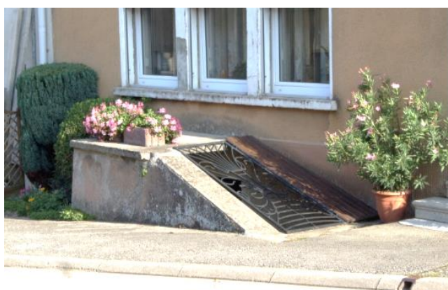
Exemple de trappe extérieure d'accès à la cave - Grand'Rue
