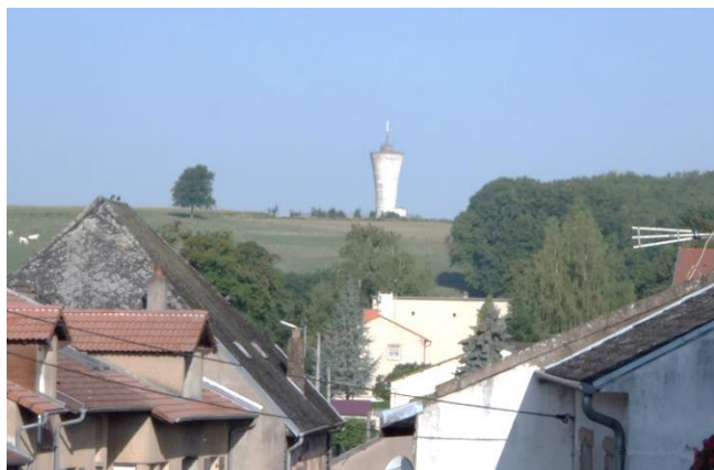
Le château d'eau vue depuis la Grand'Rue à Waldwisse
