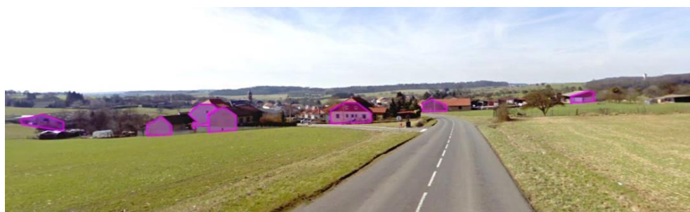
Premières constructions présentant pignons sur l'extérieur
