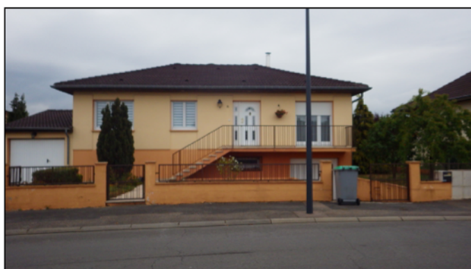
Maison avec rdc surélevé, avenue François Dupont
