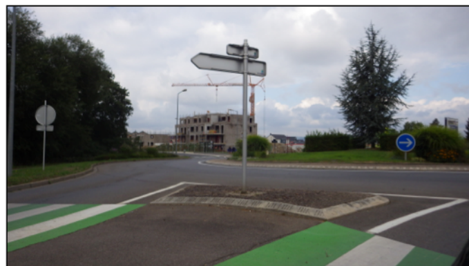
Quartier de l'Aéroparc en construction
