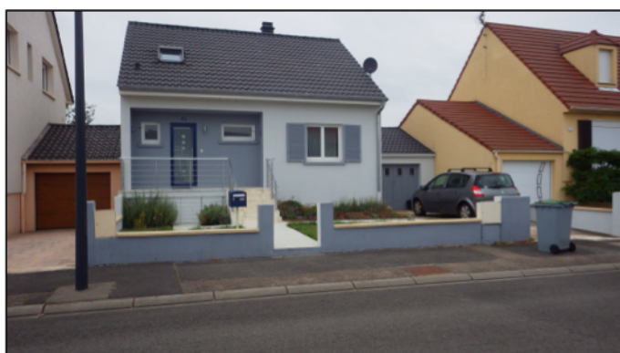
Maison avec façade refaite, avenue François Dupont
