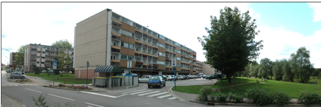
Logements HLM de Haute-Yutz (rue de Provence, de Bretagne et Dauphiné)
