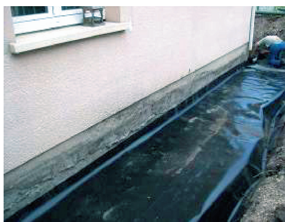
Figure 22 Géomembrane en cours de pose (Source Socabat)
