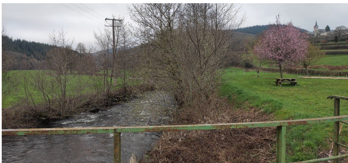
Figure 66 : Vue sur l'Yonne et l'espace aménagé attenant depuis la passerelle traversant la rivière
