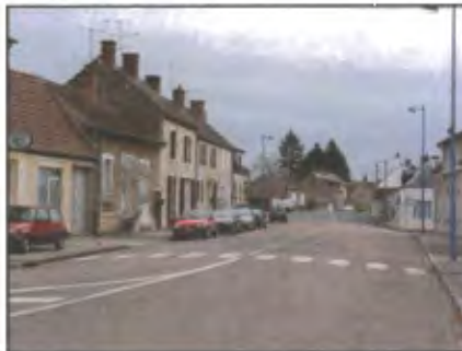
Vue restreinte dans la partie urbaine
