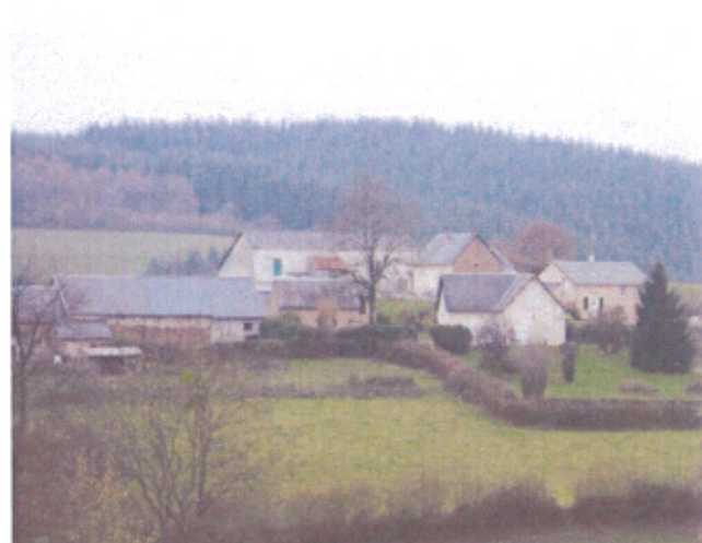
Grands pans de toiture en ardoises
