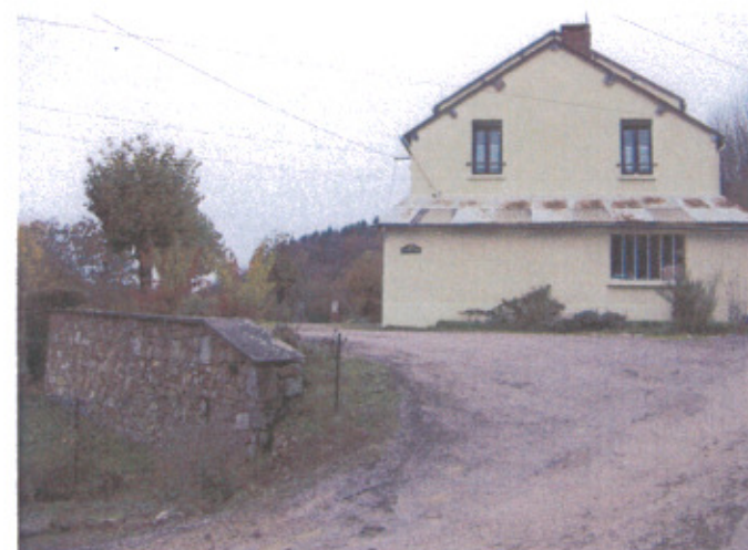
Mur de soutènement
