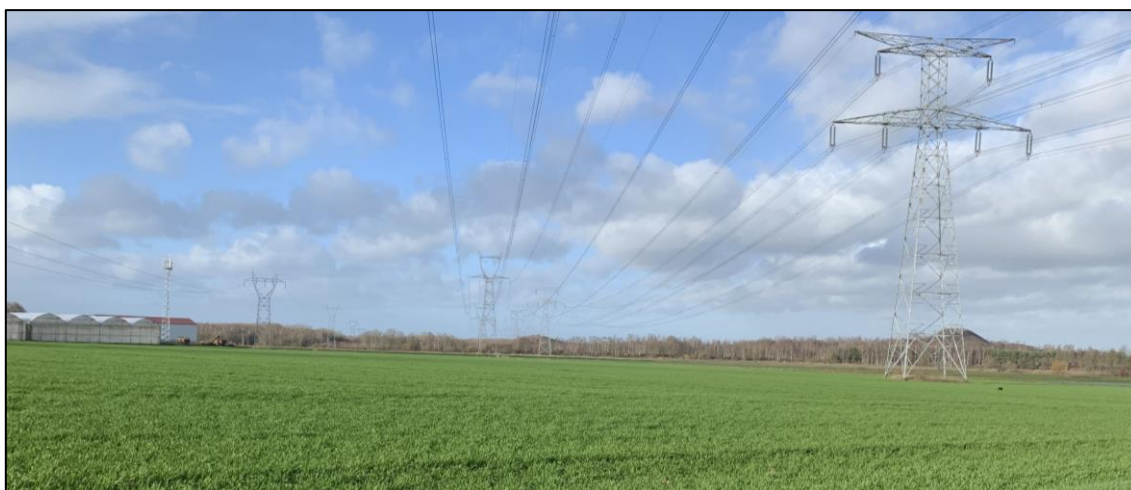
Photo 14. Pylônes depuis la rue Lesage
