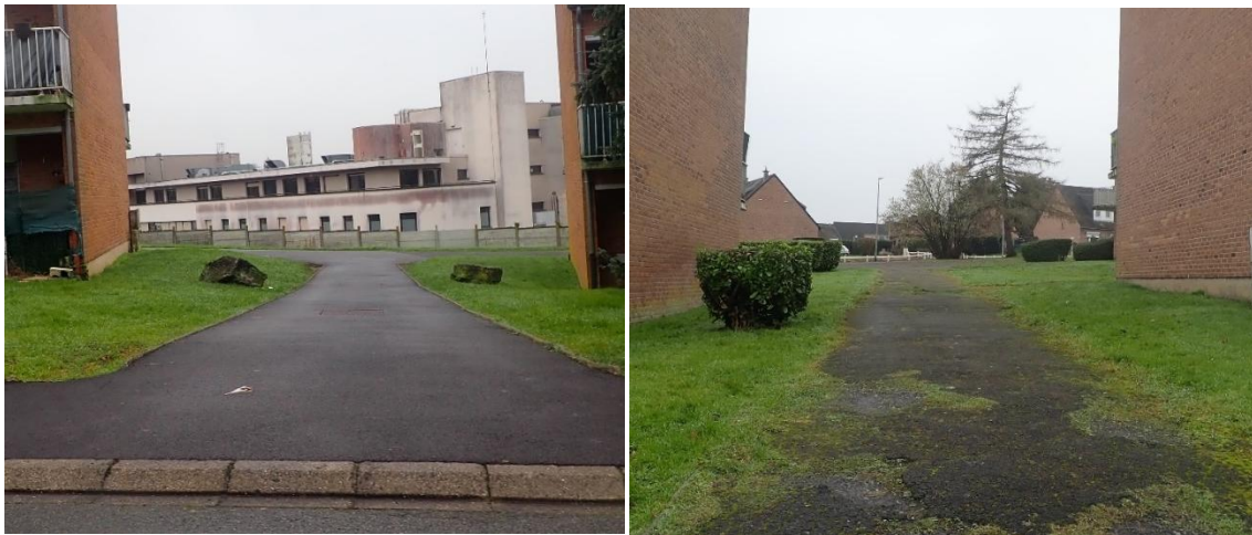
Exemples de cheminements doux communaux
