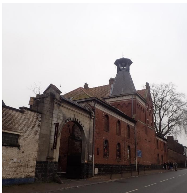
2- Ancienne brasserie-malterie Lefebvre-Scalabrino - classée partiellement MH
