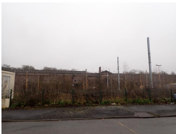
Site de la friche SIMONS, concerné par le projet de renaturation
