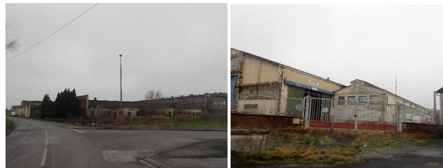
Friche de l'ancienne usine du Cateau Source : Photographies Urbycom
