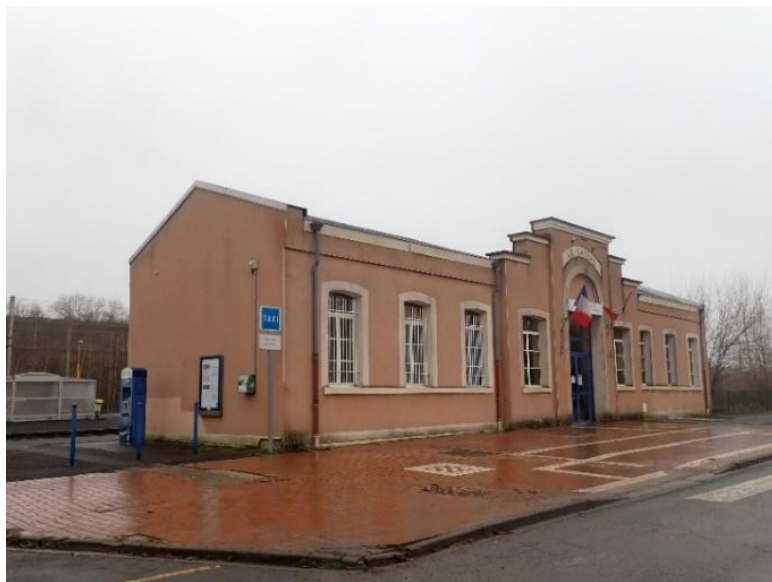
Gare du Cateau-Cambrésis Source : Photographie Urbycom
