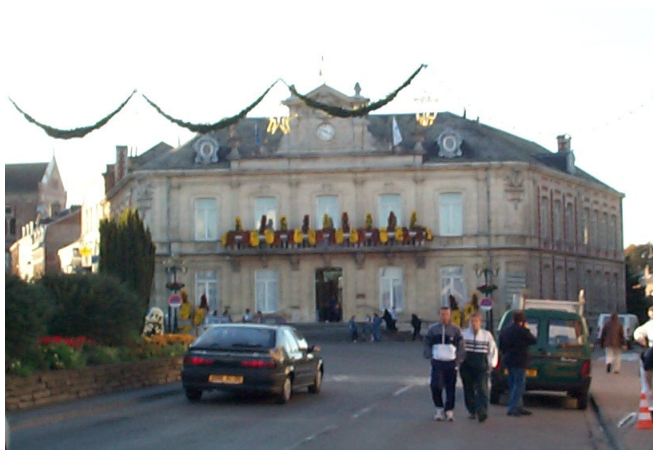
L'hôtel de ville de Caudry construit en 1875
