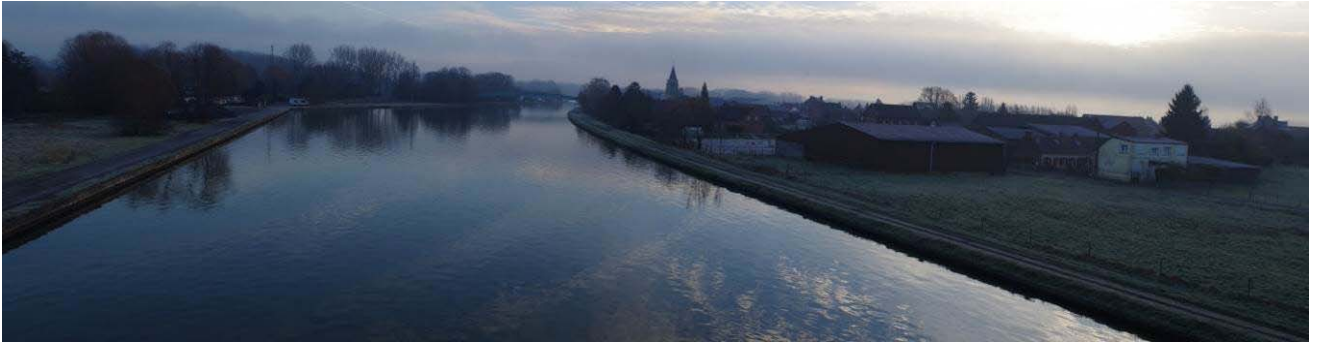
Vue 2 - panoramique à l'Est sur le pont de la D402 surplombant la Sensée canalisée : village et passerelle d'Hem-Lenglet
