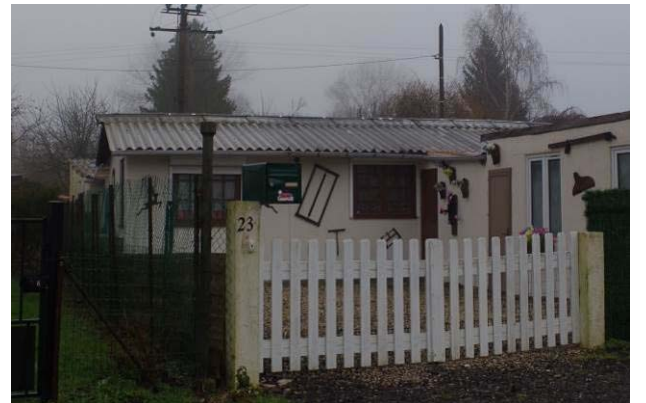
Toitures en fibrociment
