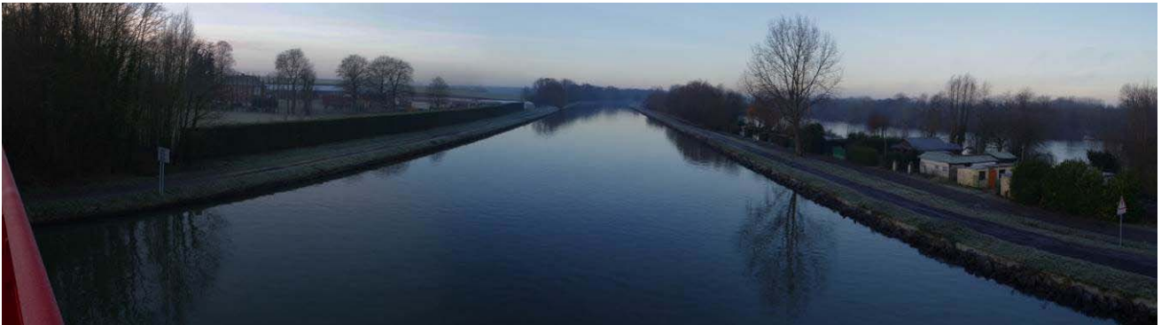
Vue 2 - panoramique à l'Ouest sur le pont de la D402 : canal de la Sensée et étangs d'anciennes tourbières
