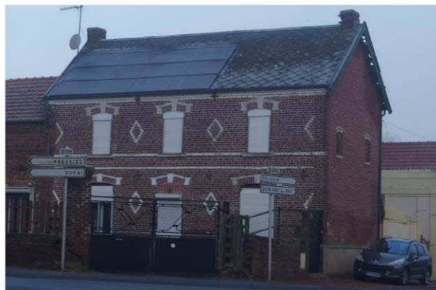
Maison groupée R+1+C de la reconstruction 1920 avec modénatures de briques décoratives.
