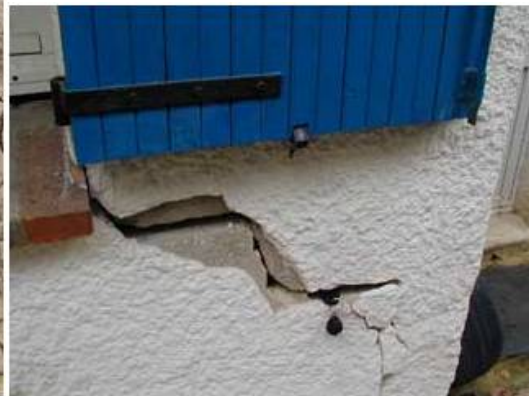
Schéma illustrant le fonctionnement de l'aléa retrait/gonflement des argiles et / Représentation des dégâts liés au risque retrait gonflement des argiles
