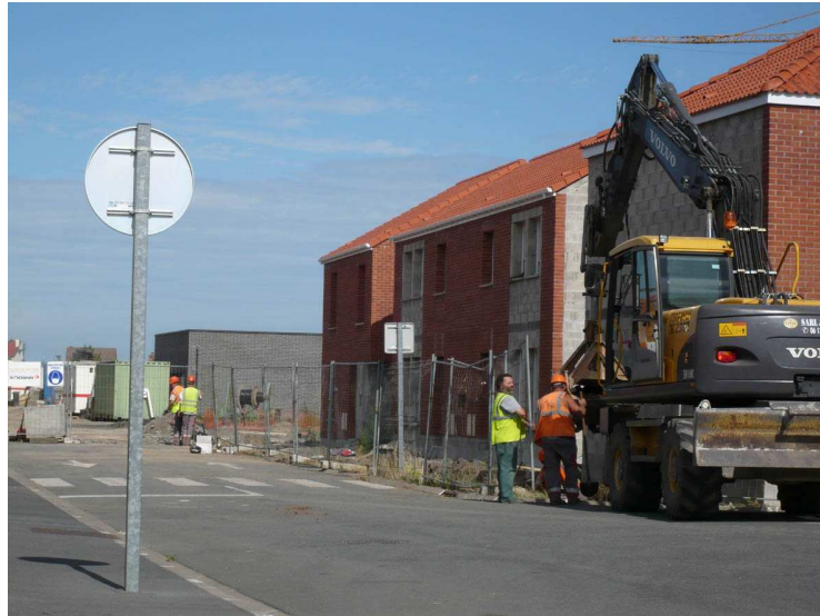
Faubourg Morelle lors des travaux
