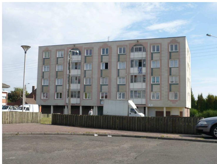
Logements collectifs rue de la Paix
