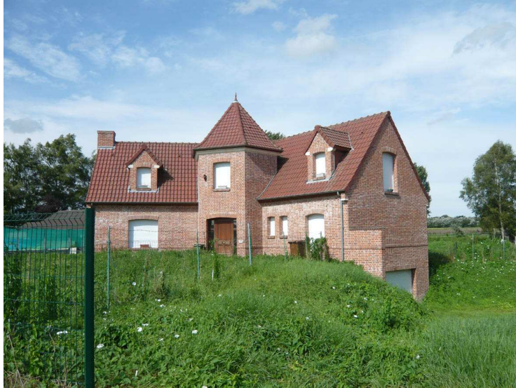
Construction pavillonnaire rue Michel Sanchez
