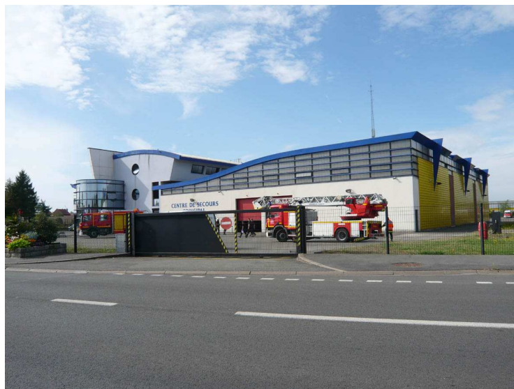
Centre de secours implanté le long de la RD917
