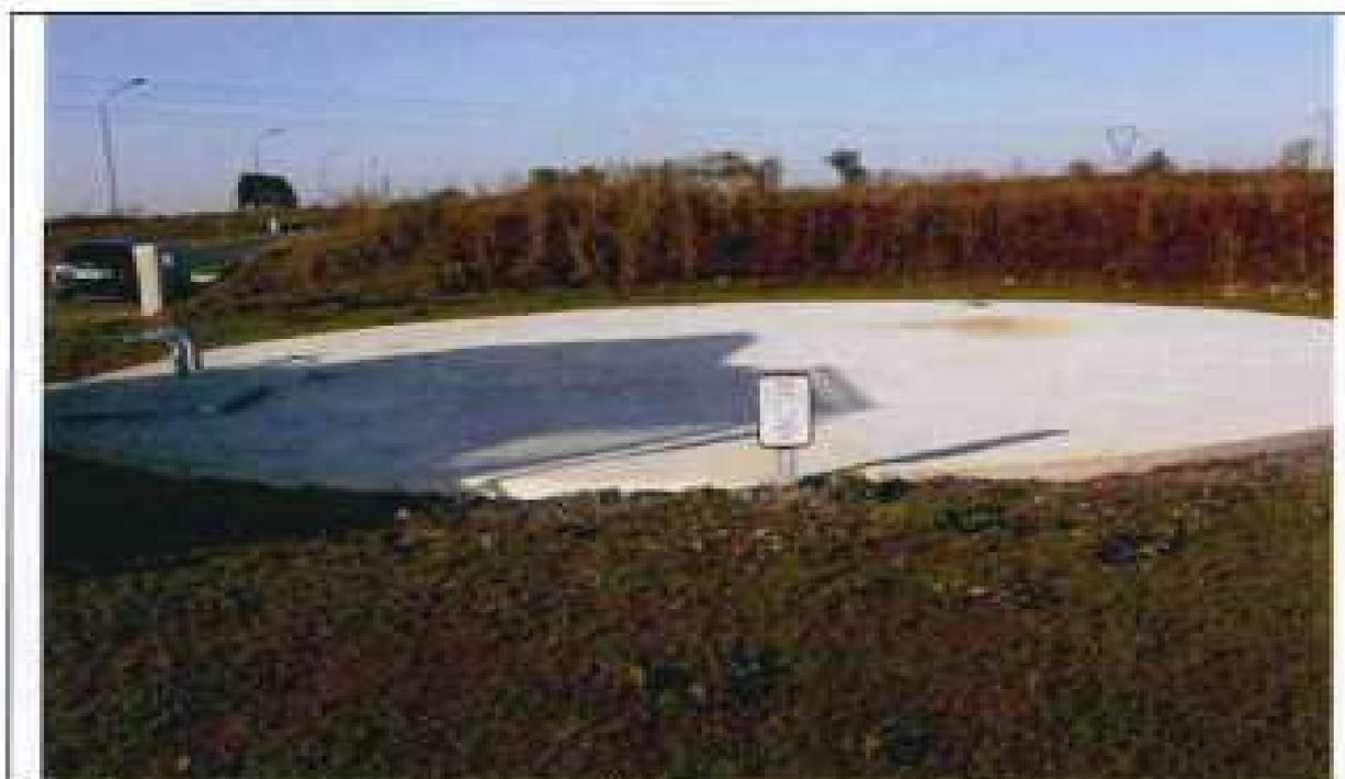
*Réserve enterrée de 240m<sup>3</sup> avec 2 sorties DN 100, une trappe d'accès permettant également le remplissage, un évier d'aspiration ainsi que la signalétique.*
