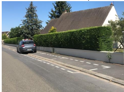
De l'enrobé bitumineux imperméable
