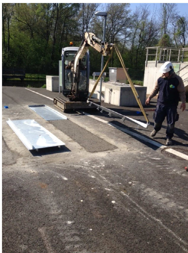
Mise en place de rails de protection du bitume pour les bennes à boue
