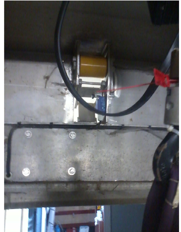
Renouvellement du motoréducteur du dégrilleur
