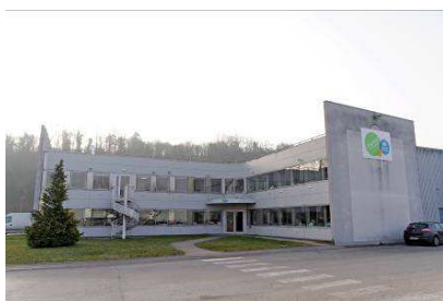
Centre technique de la Zone de Vaux à Creil
