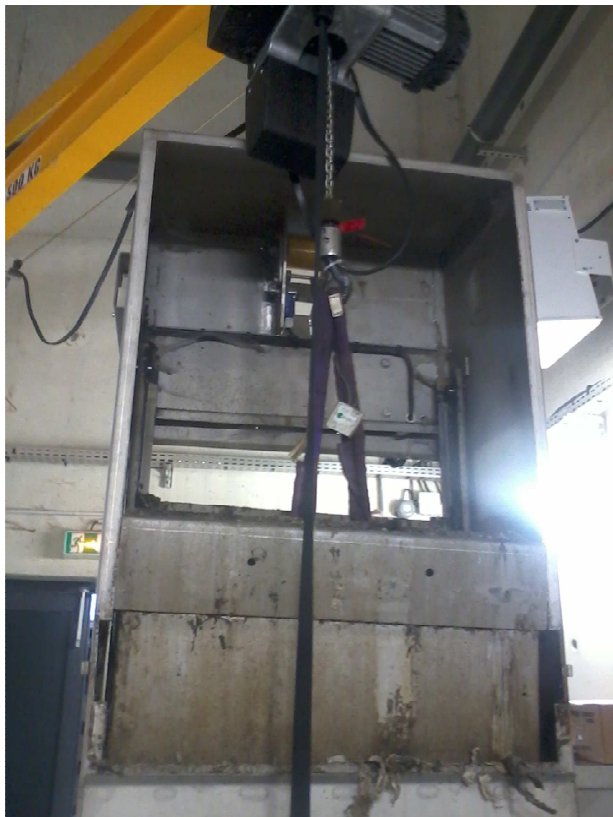
Renouvellement du motoréducteur du dégrilleur
