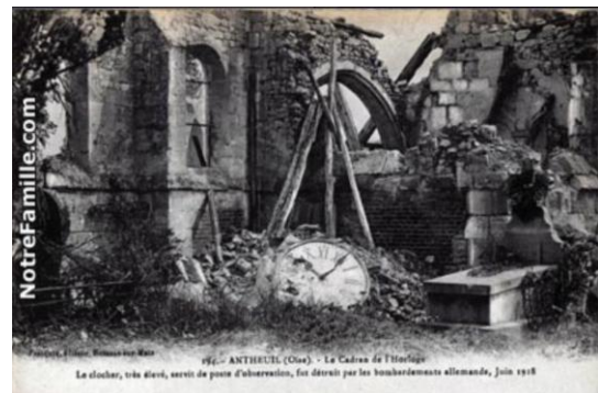
Le clocher, très élevé, servit de poste d'observation. Il fût détruit par les allemands, juin 1918
