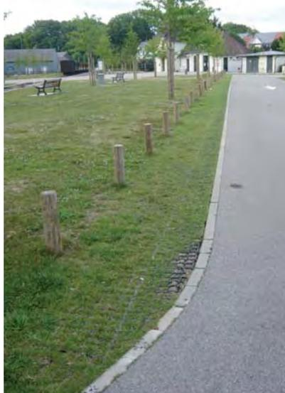
**Exemple de structure alvéolaire enherbée, Saint-Valery-sur-Somme.** Les angles, plus fragiles, sont éventuellement à traiter différemment, par exemple avec une bordure arasée large.
