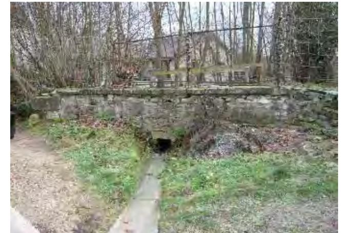
Muret en pierres, avec passage pour l'eau pluviale, situé au niveau de l'accul, à entretenir.
