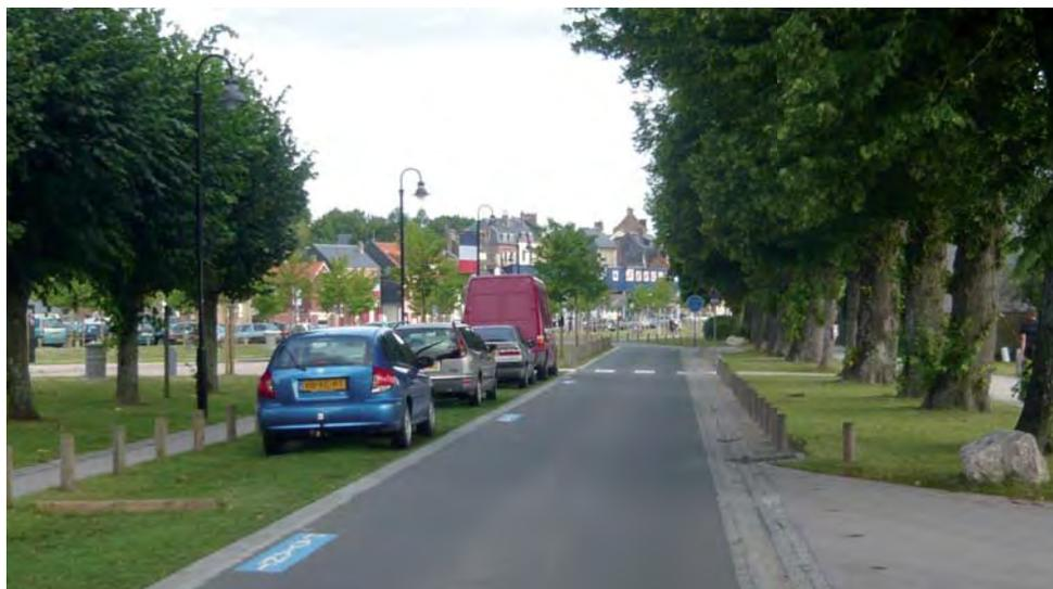
**Exemple d'accotements en surface enherbée et renforcée permettant le stationnement, Saint-Valery-sur-Somme.** Ces surfaces permettent un usage polyvalent en diminuant l'emprise des surfaces imperméables en enrobé. L'aspect enherbé des accotements participe à une qualité de l'espace public rural.
