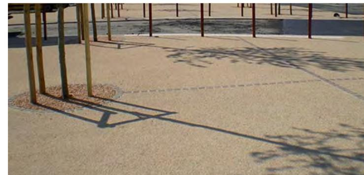
La mise en oeuvre d'un revêtement de sol drainant est recommandée pour l'infiltration des eaux pluviales.
