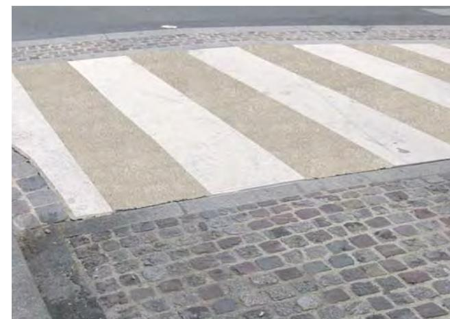
Exemple de passage piétons surélevé en béton désactivé encadré de rampants en pavés.
