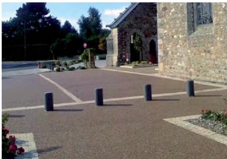
**Exemple de revêtement perméable conservant la couleur du minéral utilisé et acceptant la circulation des véhicules légers.**
