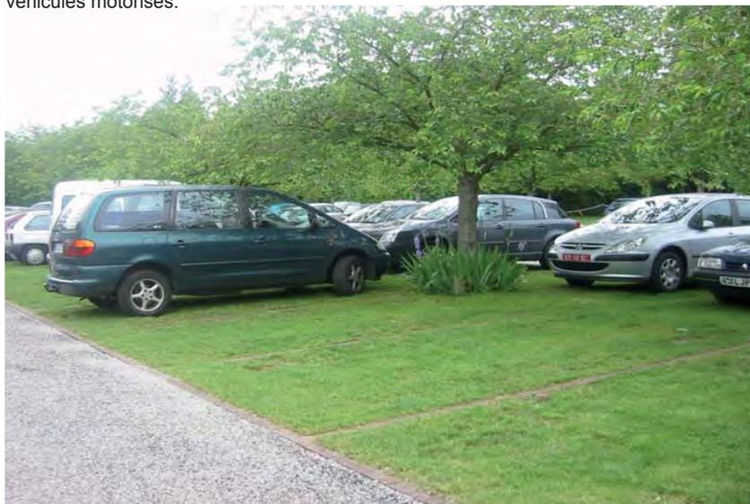
**Exemple de stationnements en surface enherbée sur structure renforcée (résultat obtenu avec structure alvéolaire PVC ou un mélange terre-sable-pierre), Giverny.** Ce type de surface pourrait être utilisé sur la placette à l'angle de la voirie du Bois de la Folie devant les habitations.
