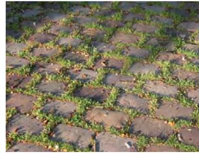
**Exemple de pavés non jointifs, posés sur sable, entre lesquels pousse de l'herbe.** Ce type de revêtement est un entre deux entre le minéral et végétal. Il peut être utilisé pour réaliser un îlot central sur la place d'Avilly.
