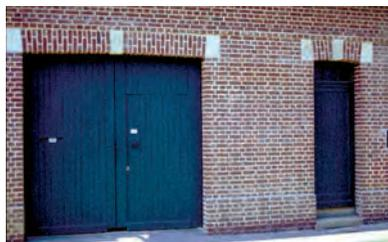
Ravalement de mur de brique, joints à la chaux avec un appareillage panerresse/boutisse, occultation par un store intégré
