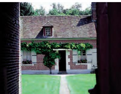
La brique est employée en alternance pour constituer le décor des linteaux, des encadrements, des corniches, des bandeaux, des harpes. Ses dimensions sont 5cm x 10cm x 20cm. Les joints sont effectués avec un mortier de chaux et de sable. Elle est parfois recouverte d'un **lait de chaux**.
