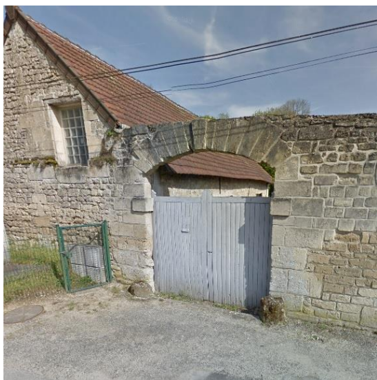
Rue des Sablons
