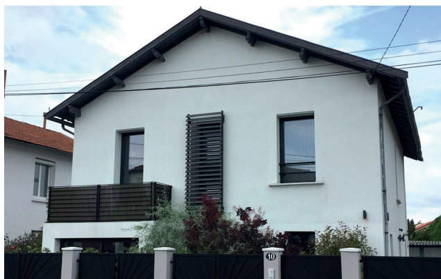
Maison des années 1950 en structure de béton avec débords de toit importants.
