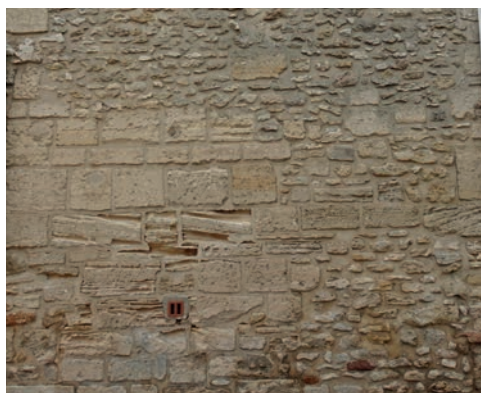
Façade en pierres de taille et moellons, Mouchy-le-Châtel
