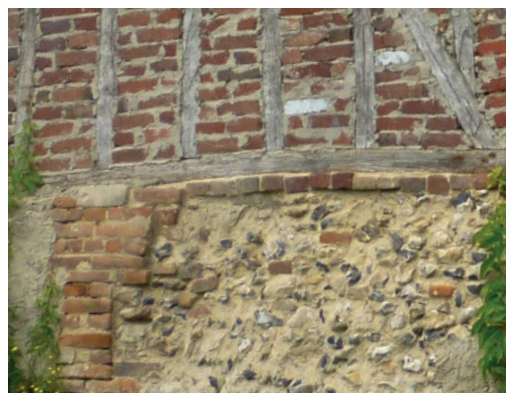
Façade composite, pans de bois, briques et silex, Silly-Tillard
