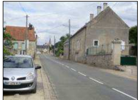
Toiture à deux pans
