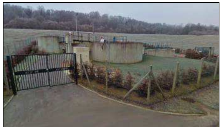
Station d'épuration communale
