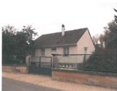
Pavillon sur sous sol semi apparent
