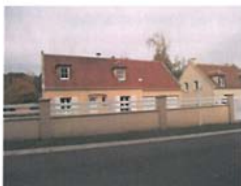
construction pavillonnaire récente
