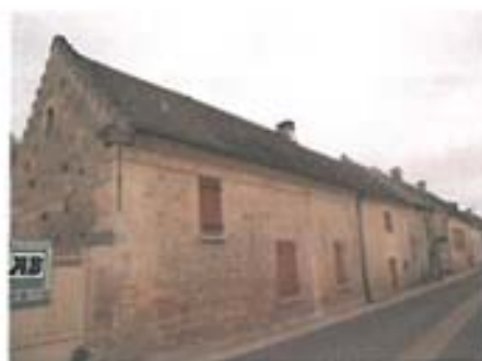
Ancienne grange en moellons et pierre de taille avec pignons à redents (Rue du Pont)
