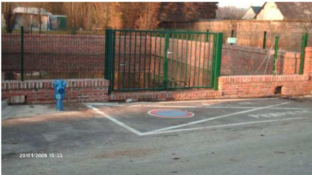
Le nombre d'aires d'aspiration devant équiper un point d'eau dépend de sa capacité en m<sup>3</sup>, et donc du nombre de sorties de 100 mm l'équipant.
