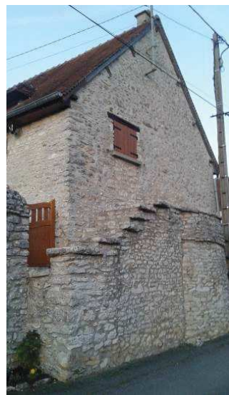
C : Escalier en pierre
