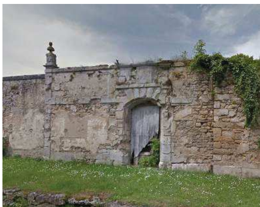
D : Mur et porche en pierre
