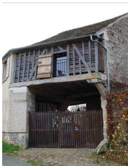
F : Ancien séchoir en bois et en pierre
