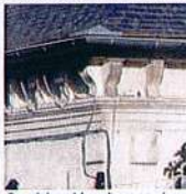
Corniche et bandeau en pierre
