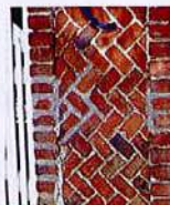
Brique rouge unie, silico-calcaire claire, vernissée et cintrée, badigeonnée en rouge, posée à chevron, formant un escalier ou un couronnement de clôture
