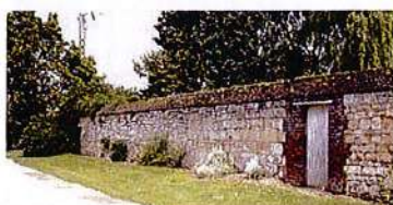
Mur de pierre en blocage avec chaînes et couronnement en brique avec bande herbacée
