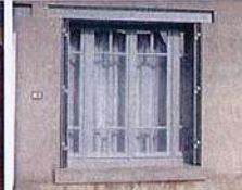
Baie avec linteau et volets métalliques pliants
