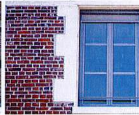
Ravalement de mur de brique, joints à la chaux avec un appareillage paneress/boulisse, occultation par un store intégré
