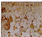
Enduit ancien sur moellon
