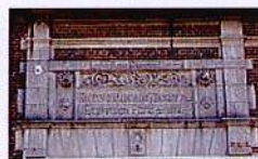
Porche en pierre ouvragée
