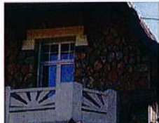
Balcon en béton d'une maison en meulière
