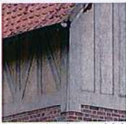
Enduit mouchetés, faux pans de bois
