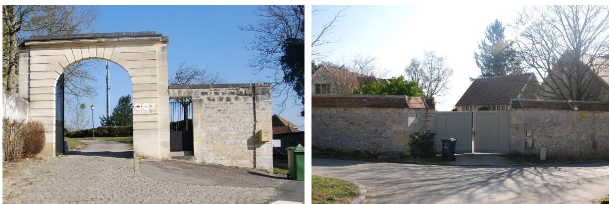
Figure 99 : Exemples de murs protégés
