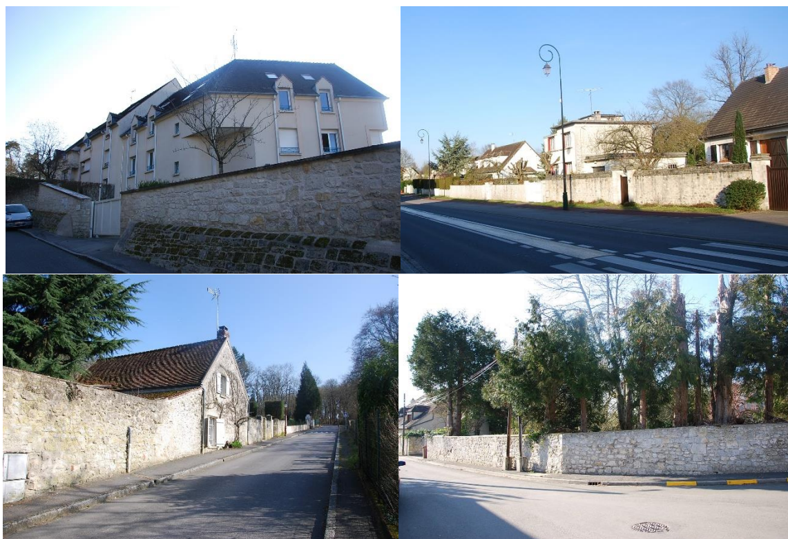
Figure 96 : Exemples de murs protégés
