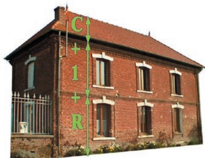
Hauteur d'une maison du village
