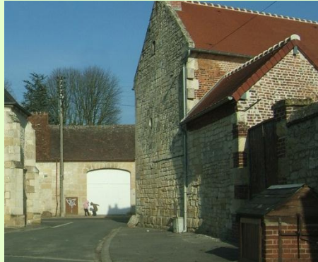
Construction traditionnelle d'intérêt
