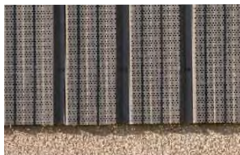
Enduit et bac acier
