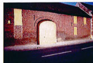
Grange avec porte charretière
