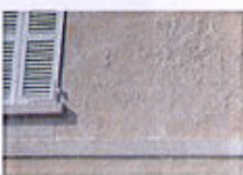
Ravalement d'enduit sur moellon
