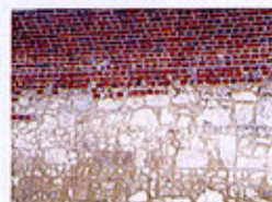
Brique et moellon calcaire
