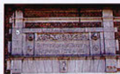
Porche en pierre ouvragée
