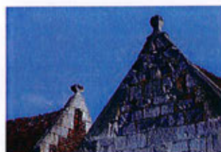
Pointes de pignon avec fleurs de maçon
