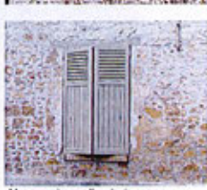
Maçonnerie moellon à pierre vue
