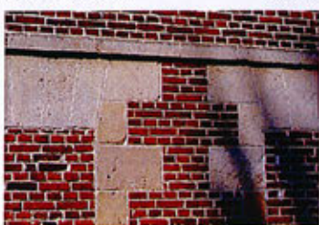
Mur de brique avec bandeau et encadrements en pierre de taille
