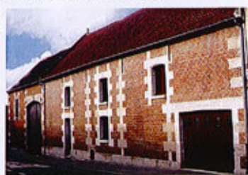
Réutilisation d'une grange en logement
