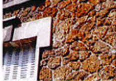
Meulière avec joint creux au mortier bâtard
