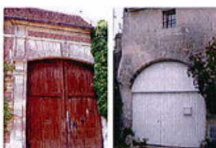
Porche d'entrée avec encadrement ouvragé en pierre
