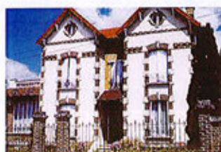
Modénatures : céramiques, bandeaux, corniches, harpes, encadrements
