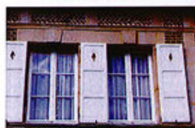
Brique chevron, linteau pierre
