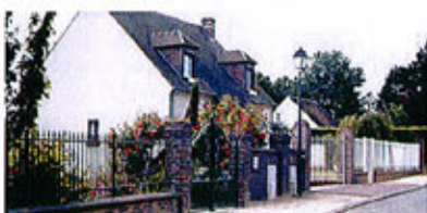
Clôtures construites avec les matériaux locaux : murets de brique rouge surmontés de ferronnerie
