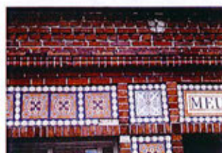
Modénatures : céramiques, bandeaux, corniches, harpes, encadrements
