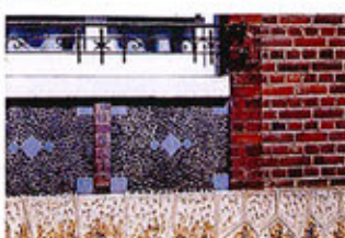
Modénatures : céramiques, bandeaux, corniches, harpes, encadrements
