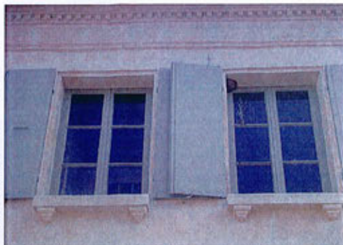
Comiche avec denticules, appuis de fenêtre et feuillure en pierre de taille avec joints à la chaux arasés au nu de la pierre
