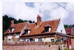
Cheminées massives et lucarnes à capucine
