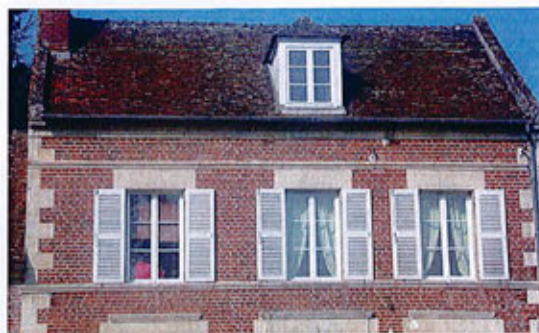
Maçonnerie mixte, volets peints persiennés
