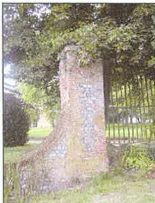
On trouve également des murs composites alternant briques, , silex, à l'image du muret du château (ci-contre : l'un des pilastres du portail principal)
