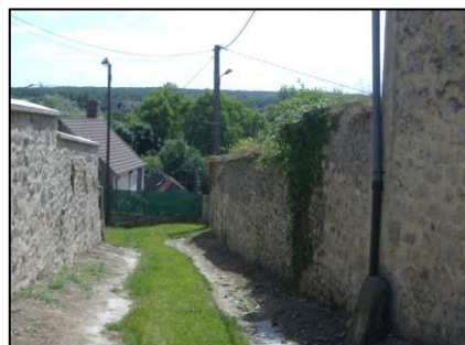
Clôtures le long d'une voie
