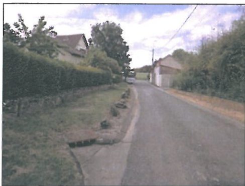
Puits d'infiltration dans la Rue de l'Eglise
