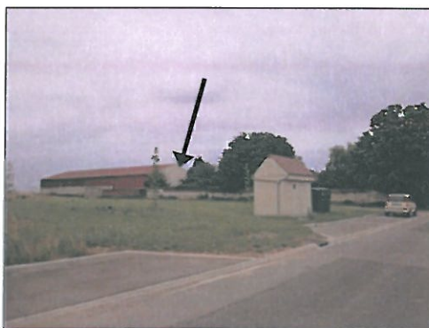
Puits d'infiltration dans la Rue d'Amiens
