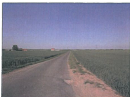
VC n°282 de Moulin Lagny
