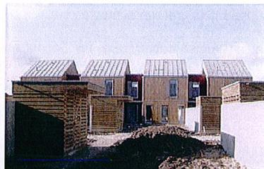
Un volume simple et compact, avec moins de surface de murs extérieurs à isoler, se révèle moins onéreux à la construction. Cela permet de gérer les pertes et apports de chaleur « naturelle » et de maîtriser la consommation d'énergie.
