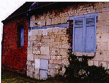
Les pignons brique et pierre sont courants dans le Pays Compiégnois. Si la pierre utilisée est tendre comme la craie, elle est protégée par un rampant qui peut être de brique : le couteau picard. La brique est disposée à 45° en dents de scie ; le corps du pignon est souvent un montage de brique et pierre alternées. La jonction avec la toiture est faite avec un solin au plâtre ou au mortier bâtard.
