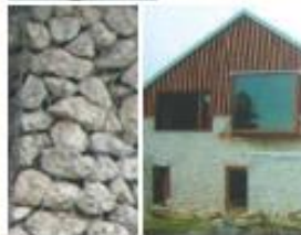
Matériaux : résilles métalliques pour plantes grimpances, mur en gabion (caisson en treillage métall rempli de caillasse), pignon en maçonnerie enduit à pierre nue et cils de bois associés aux fenêtres cadrées
