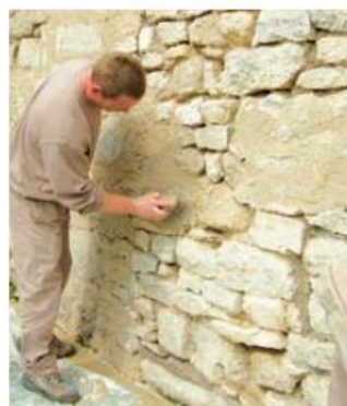
Rénovation à la chaux
