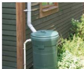
Collecteur d'eau de pluie sur gouttière
