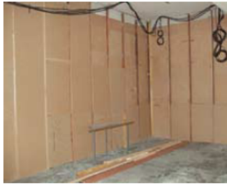
Isolation d'un mur
