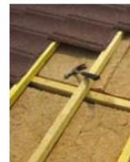
Isolation d'une toiture
