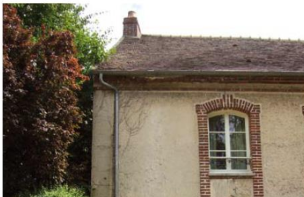
Fenêtre rénovée (bois) double vitrage
