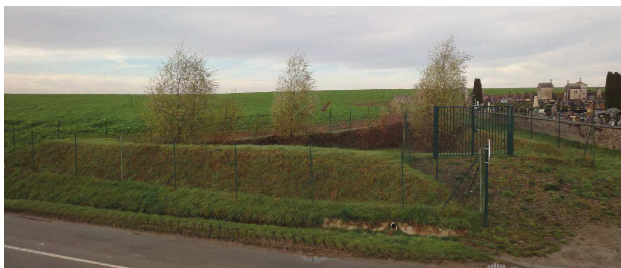
Bassin de collecte des eaux pluviales au sud de la rue de l'église
