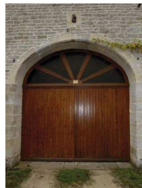
Porte pleine et imposte vitrée - Arc cintré
