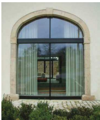
Porte vitrée - Arc cintré
