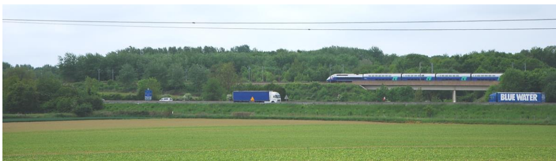
Territoire communal traversé par deux infrastructures majeures : l'autoroute A1 et la Ligne à Grande Vitesse Paris-Lille
