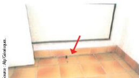
Affaississement du plancher mis en évidence par le décollement entre plinthes et dallage - Maison Jourdan.
