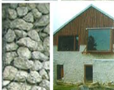
Matériaux : résilles métalliques pour plantes grimpantes, mur en gabion (caisson en treillage métal rempli de caillasse), pignon en moellon enduit à pierre vue et clin de bois associés aux fenêtres cadrées
