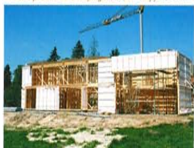
Chantier d'une maison à ossature bois
