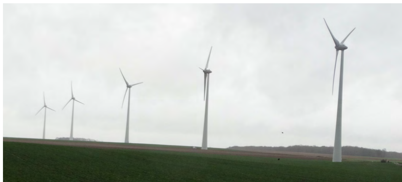
La parc éolien de Campremy / Bonvillers
