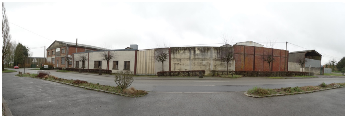
Le site de l'ancienne sucrerie depuis la rue Lucien Sueur aujourd'hui
