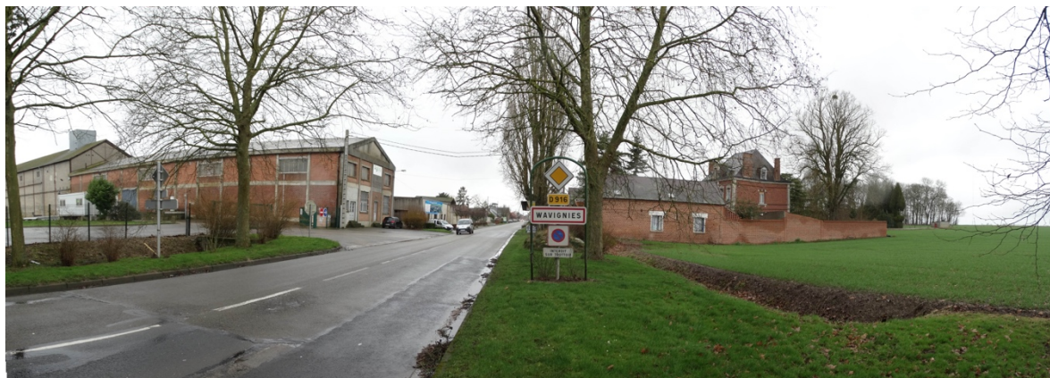
Le site de l'ancienne sucrerie depuis l'entrée de bourg
