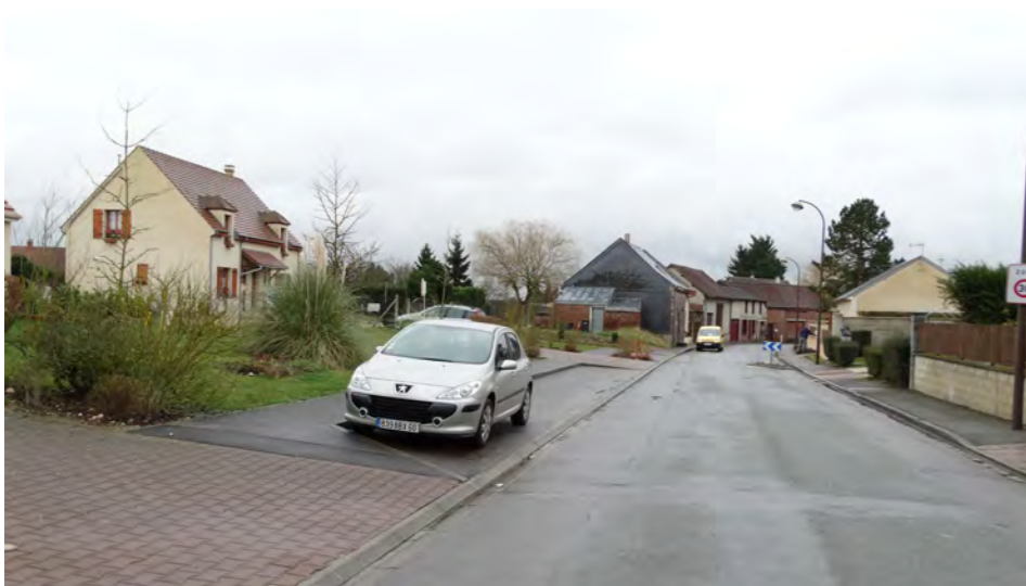
Des aménagements visant à réduire la vitesse sur la RD543 : zone limitée à 30 km/h, chicanes liées au stationnement... permettent de sécuriser les déplacements à proximité des équipements et commerces.
