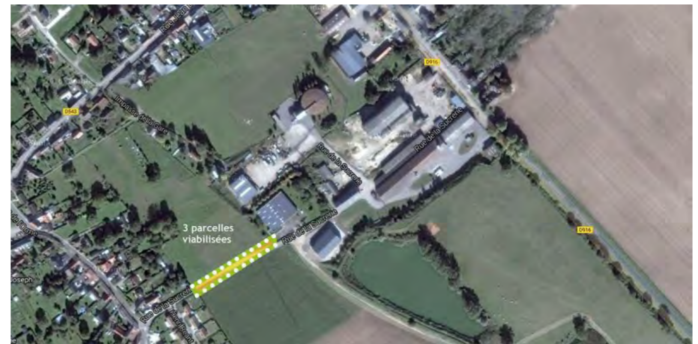
Viabilisation de la zone d'activités intercommunale
