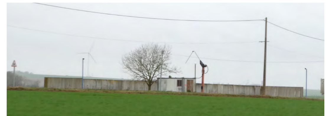
Coopérative agricole avec silos plats situés sur la D23
