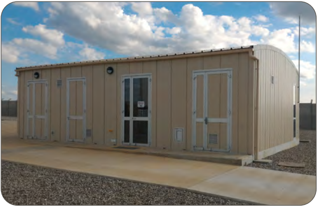
Exemple de bâtiment technique
