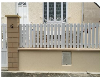
Clôture à lames PVC verticales sur mur bahut
