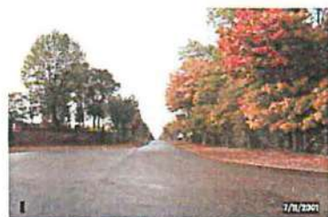
Boulevard de la fosse 11
